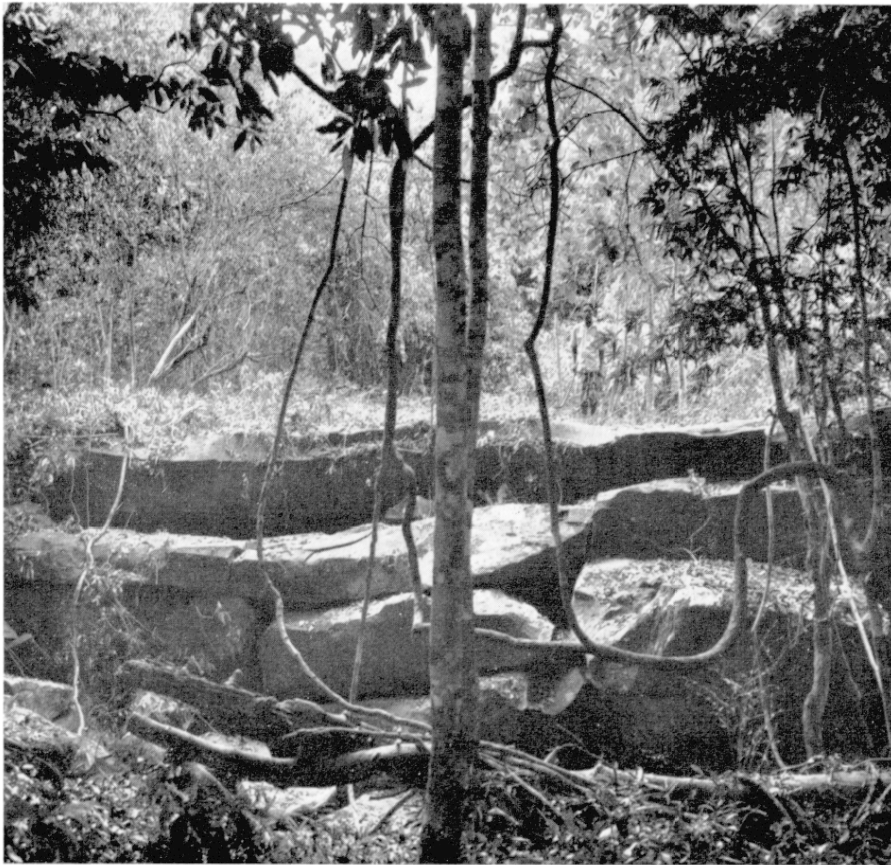
Photo 11. - Kpāl Sbān 43 : Le « pont » vu d'aval (Ph. J. B.).
