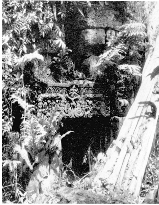
Photo 68. Prāsād Paṅguoy Sud 23 : Pavillon d'entrée Est, Face Ouest (Ph. J. B.).
