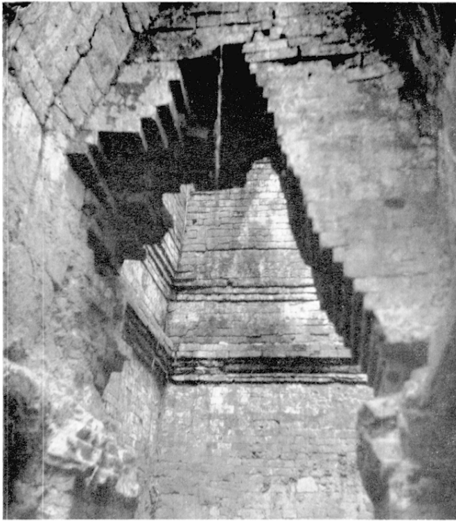
Photo 18. — Prāsād Bhuaṃ Hap 35 : Vue de la cella ( Ph. J. B. ).
