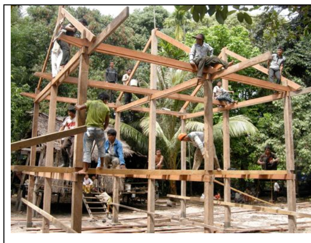
Fig. 22 : Premier jour de la construction d'une maison. Assemblage de la structure en bois avant la pose de la panne faitière. Village d' Anlong Thom, Phnom Kulen ( Photo F. Luco février 2009).
