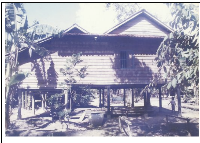
Fig. 14 : Pignon Ouest - la fermeture est presque totale (Photo F. Luco 1995)
