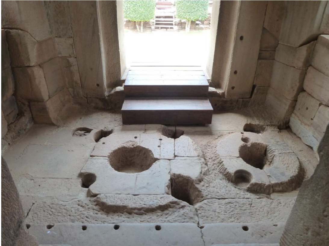
Photographie 6 : Phimai, vue de l'avant-corps depuis la porte sud du mandapa .
