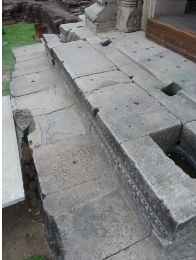
Photographie 10 : Phimai, traces d'appareillage et séries de logements sur le perron sud.
