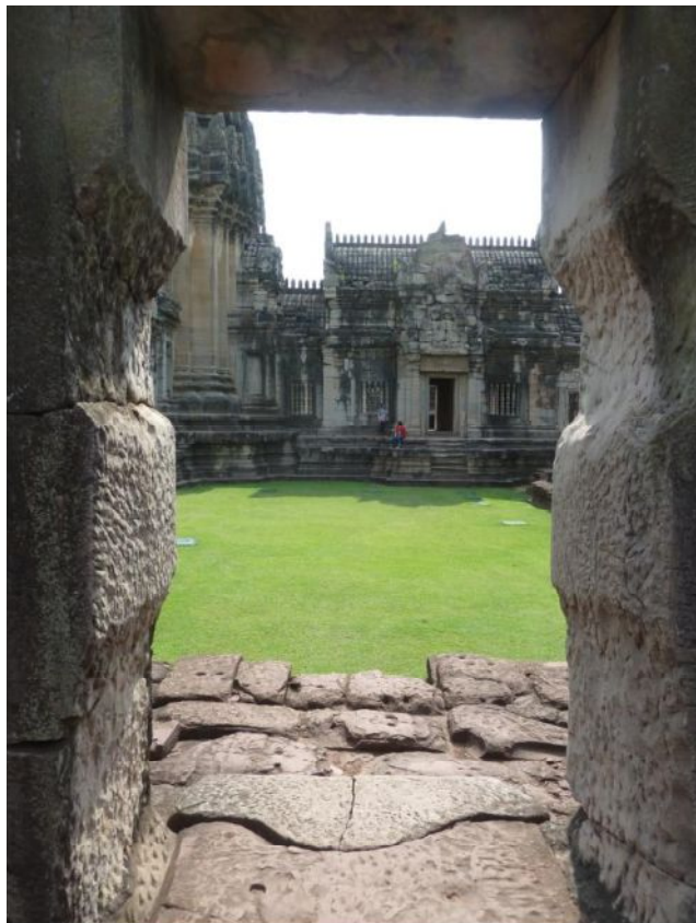
Photographie 11 : Phimai, piochement des montants et réparation du seuil de la porte orientale de l'aile sud du gopura occidental de première enceinte.
