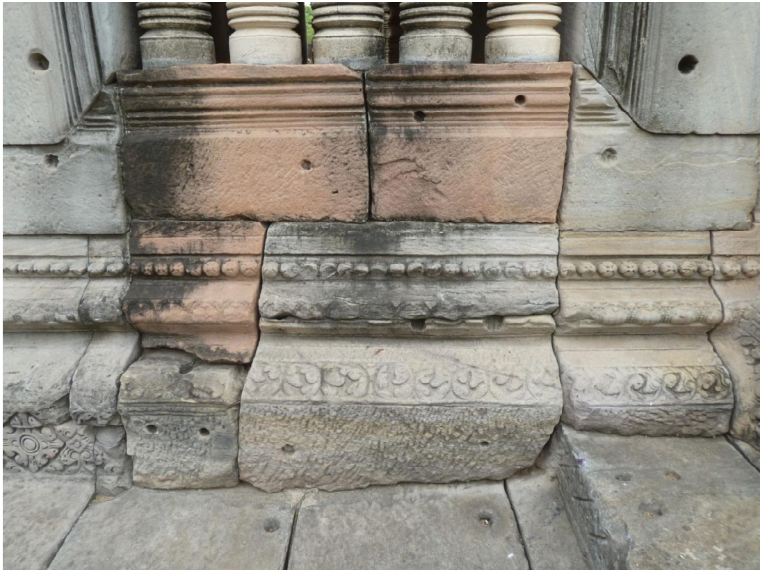
Photographie 9 : Phimai, face extérieure du bouchage sur le mur est de l'avant-corps.
