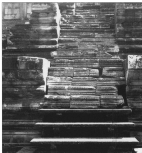
Fig. 12. Escalier Sud après remontage (état actuel).
