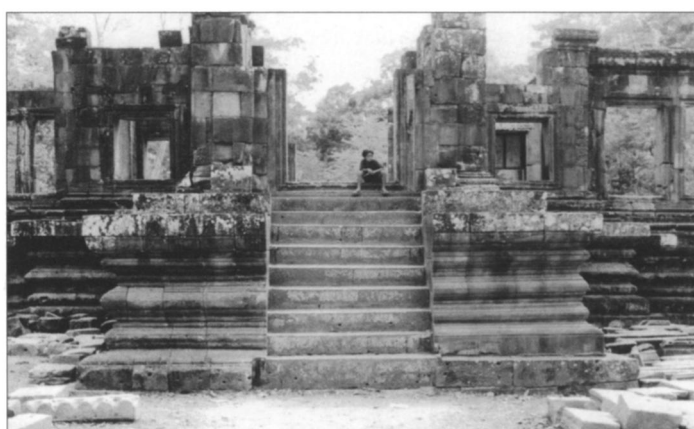
Fig. 10. Escalier Nord du pavillon IV médian (état actuel).
