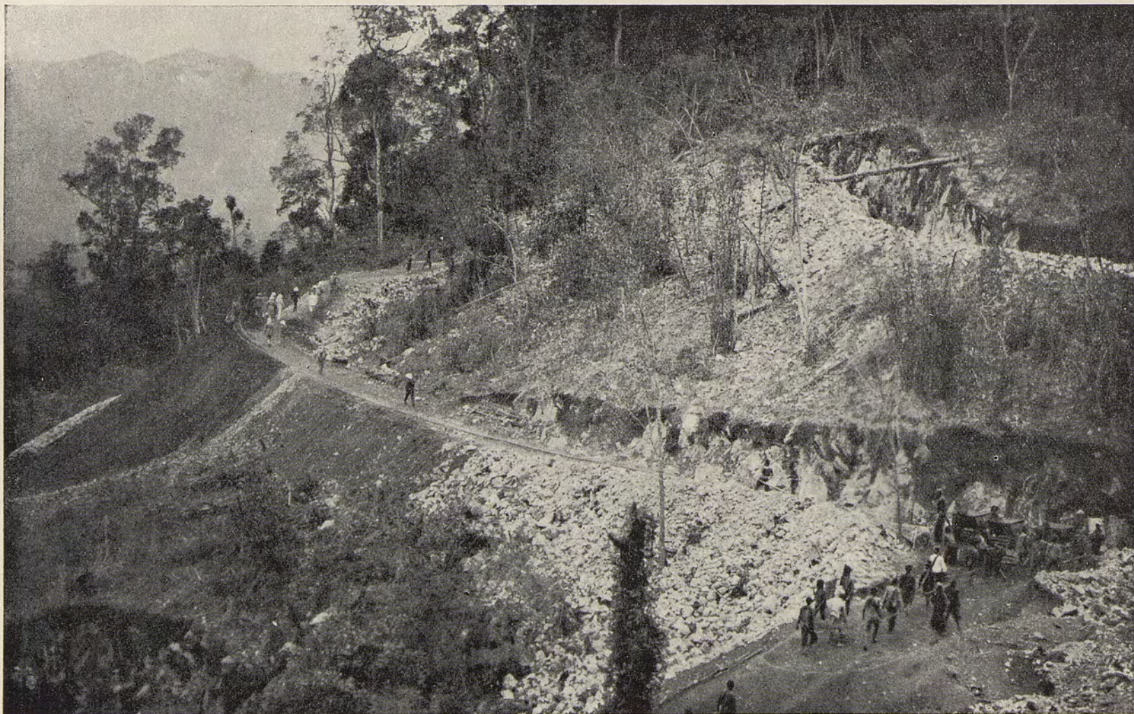
Travaux au col Paillotte.
