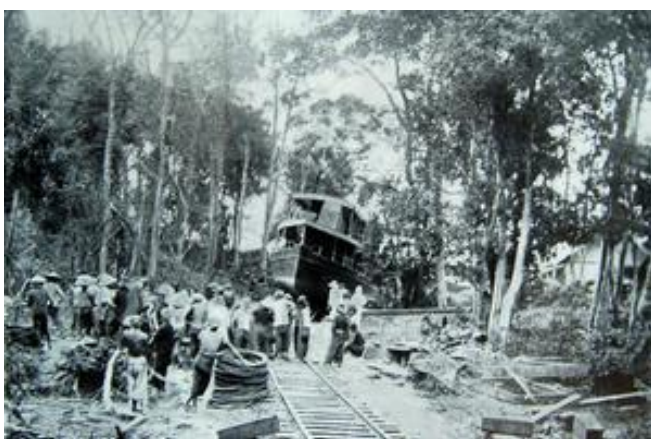
Fig.18 Passage sur la voie ferrée de l'île de Khône.
