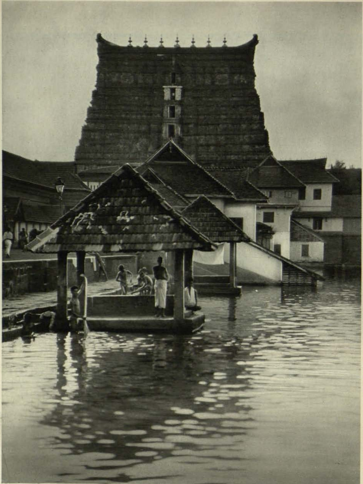
Trivandrum. Teich und Haupttempel Trivandram. Bassin et temple principal
