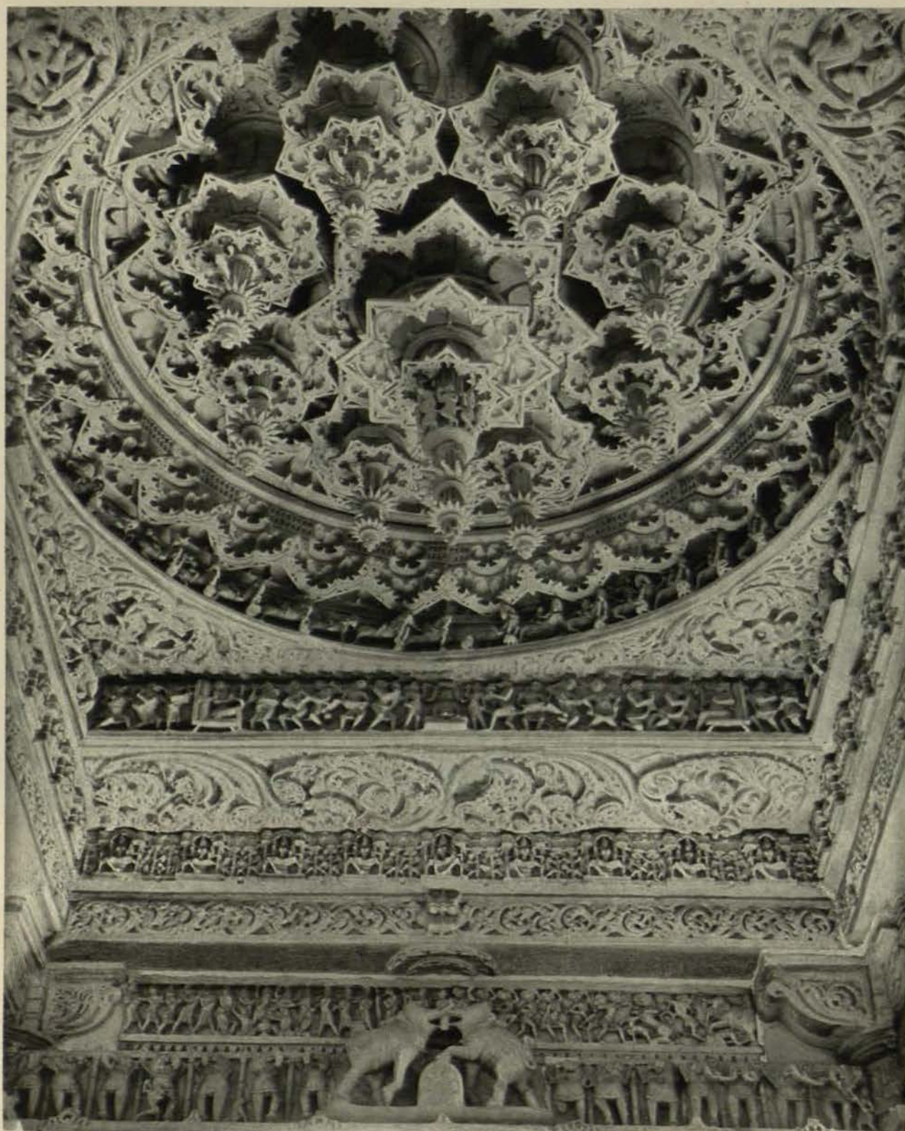
Mount Abu, Dilwara. Decke einer Seitenkapelle im Adinath-Tempel
