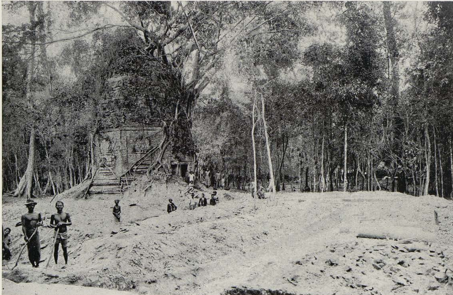
UN DES MONUMENTS DE SAMBOR-PREI KUK en cours de dégagement.
