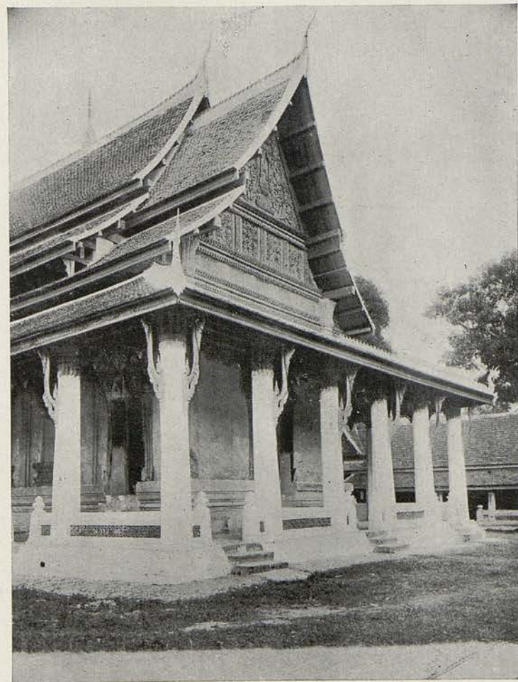
Après la restauration.
