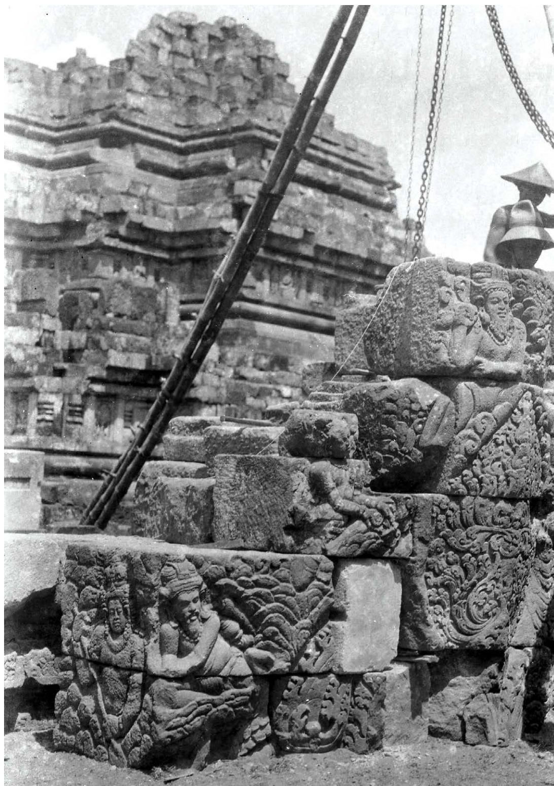
FIGURE 1 : Technique d'anastylose à Prambanan, Indonésie, avril 1928 © Archives familiales Cœdès
